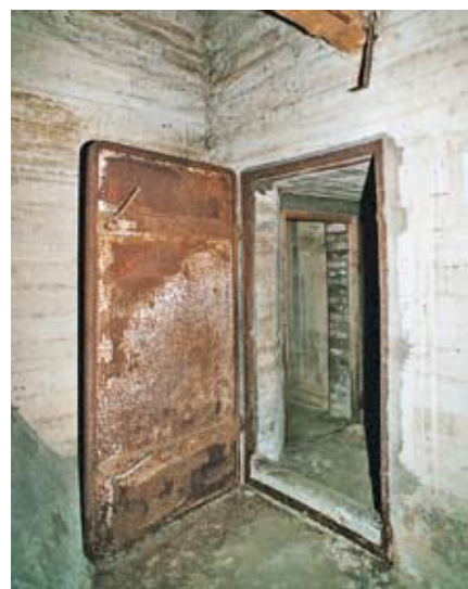
Abb. 18 Originale gasdichte Notausstiegstür von 1939 Foto 2002: M.-L. Sobczak
