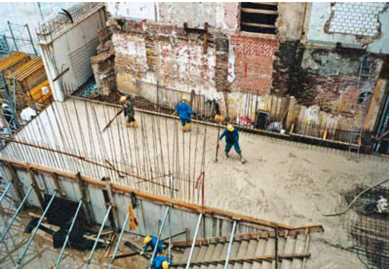
Abb. 26 Innenhof / Zustand September 2003.
