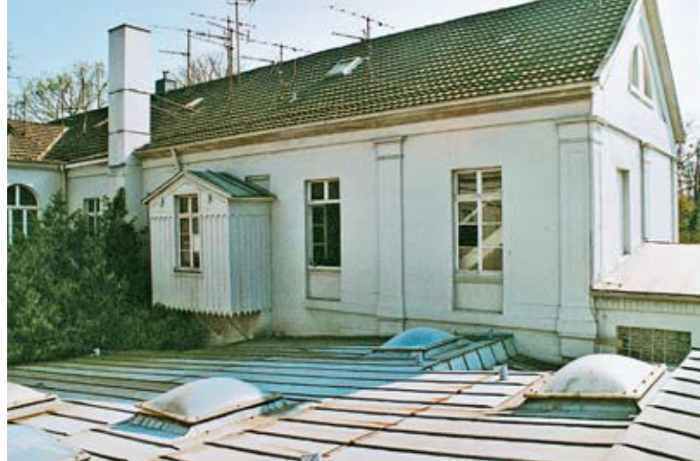
Abb. 22 Außenliegende Toilettenhäuschen / Zustand Februar 2002.
